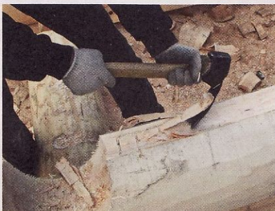
Тесло — специальный топор, очень удобный при вырубках продольного паза в брёвнах сруба.
