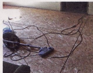
После укладки листов ОСП тщательно их пылесосим.
