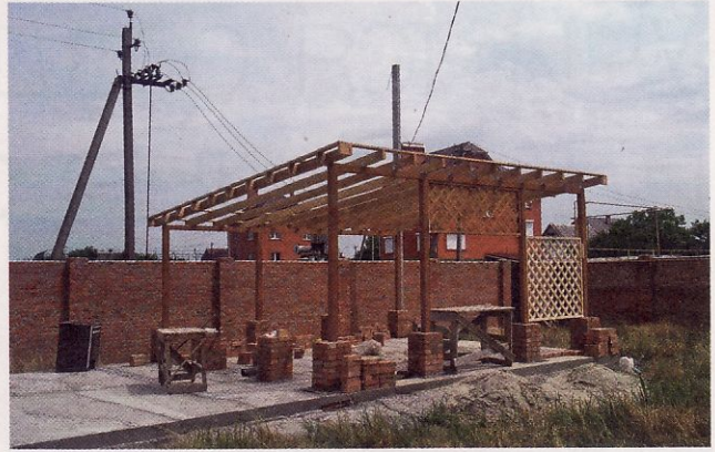
Монтаж стропильной системы и проверка установки шпалер.
