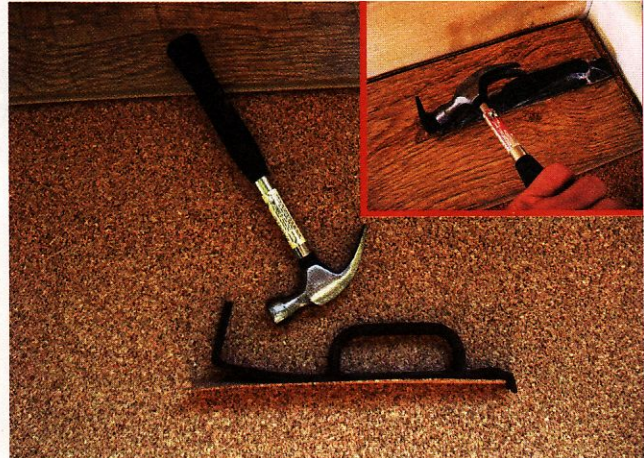
Самодельная скоба для добивания последних панелей у стены.
