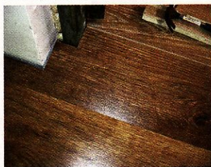
Укладка ламината у дверных коробок.
