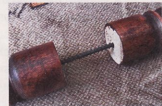
Соединение балясин.
