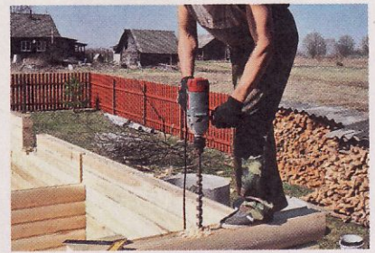
Электродрель большой мощности необходима для высверливания отверстий под нагели.
